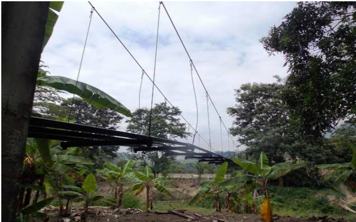
Reconstrucción de puente peatonal metálico colgante del Sitio La Cruz.
