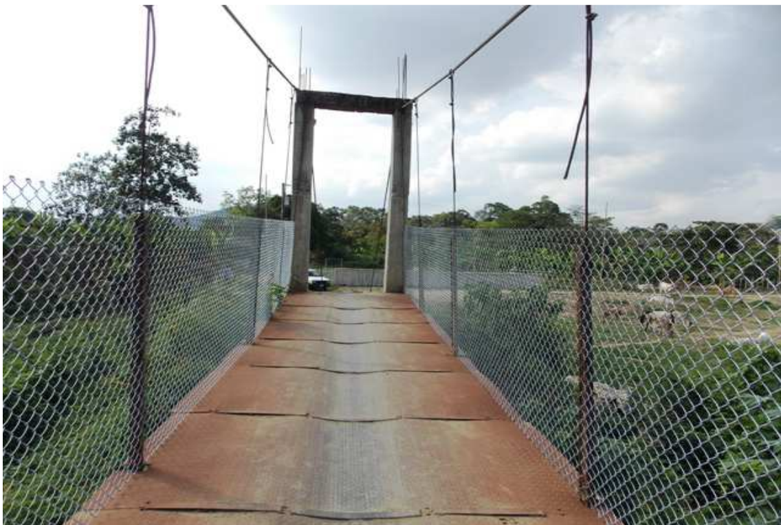
Protección Lateral con malla h- 1.50 mt en el Puente Colgante El Desvío
