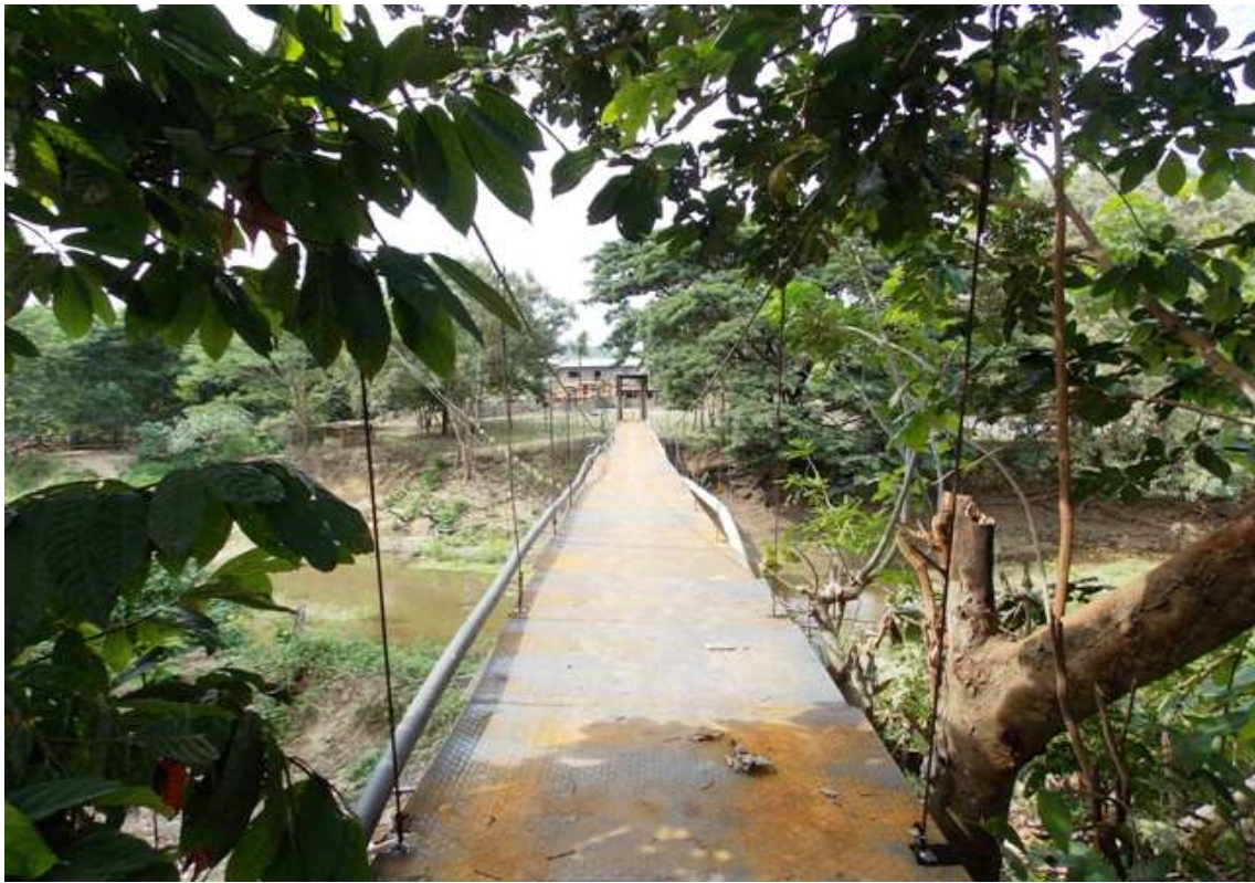
Protección Lateral con malla h- 1.50 mt en el Puente Colgante El Desvío
